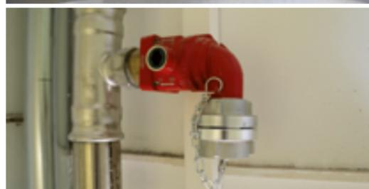
ser an speziellen Hydranten entnehmen. Zusätzlich wurden 16 Einspeisestellen an der Außenwand installiert.
